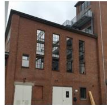
Aktuell wird noch teilweise Um- und Ausgebaut; das Gebäude des zukünftigen Mänerschuppen auf dem ehemaligen Schaeffler-Firmengelände in Bamberg
